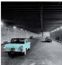
Sarnafil® fu applicato per la prima volta nel 1966 per la realizzazione del tunnel svizzero.
