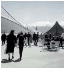
Padiglioni tenda realizzati con Sarnafil® all'Expo 64 in Svizzera.
