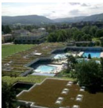
Il primo tetto Sarnafil® con giardino pensile è stato realizzato nel 1969 ed è ancora in servizio.
